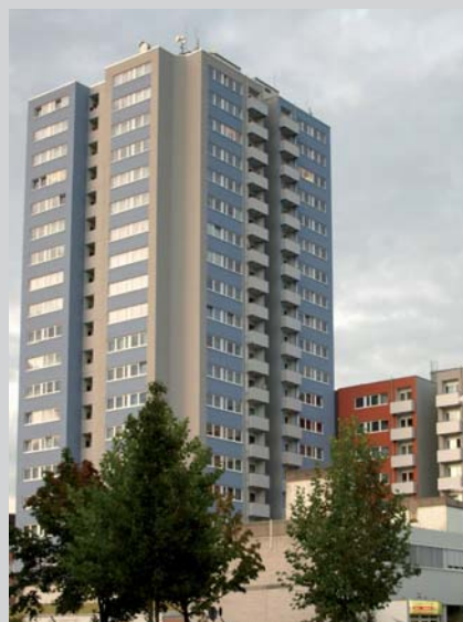
8: Das neue Bild nach der Instandsetzung
