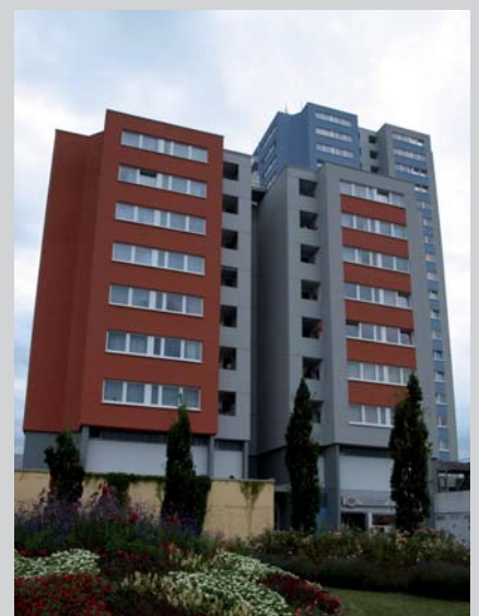
9: Fertig gestellte Südsicht des kleinen Hauses
