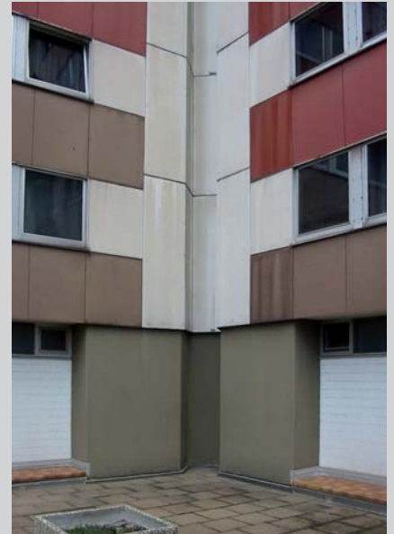
3: Alle Baustoffe auf einen Blick
