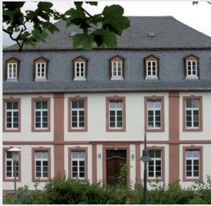
Abb. 1: Denkmalgeschützte Barockfassade: Allein der Gedanke an eine allesüberdeckende außen angebrachte Wärmedämmung ist erschreckend.
