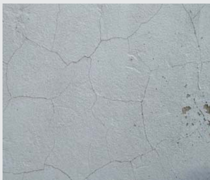
Abb. 1: Typische netzartige Schwindrisse in Putz und Anstrich
