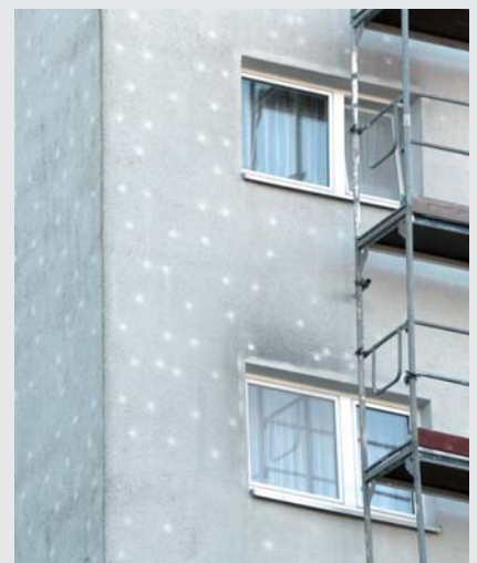
Abb. 9: Die Köpfe der Tellerdübel zeichnen sich als helle Flecke an der Oberfläche ab, da die Dübel selbst als punktuelle Wärmebrücken wirken, die schneller trocknen als die übrige Flächen.
