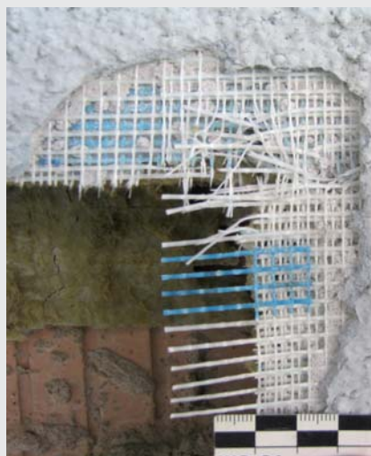
Abb. 8: An dieser Stelle überlagern sich drei Gewebelagen, so dass sie eine regelrechte Trennschicht bilden.
