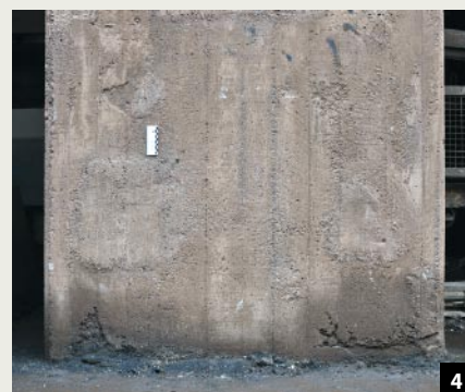
Abb. 4: Eine der Stützen im Detail: Die gesamte sichtbare Ansichtsfläche wurde neu hergestellt, mit einem Kern aus Spritzbeton zur Sicherung der Tragfähigkeit. Die letzten 15 Millimeter wurden mit Restaurierungsmörtel und originalgetreuer Brettchalungsstruktur restauriert.
