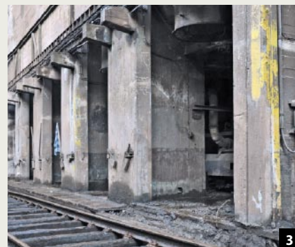
Abb. 3: Stützen des Rohstoffbunkers nach der Restaurierung: Alle Kanten der Stützen sind bis circa 1,20 Meter über Gelände neu reprofiliert und im Kern mit Spritzbeton instand gesetzt worden.
