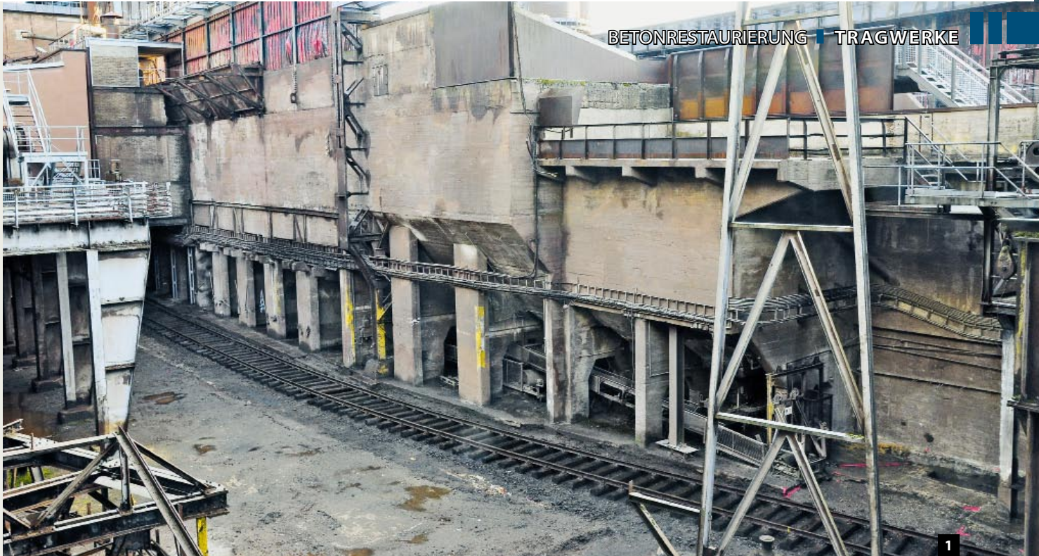
Abb. 1: Am Rohstoffbunker des Weltkulturerbes Völklinger Hütte wurde eine Betonrestaurierung unter denkmalpflegerischen Gesichtspunkten umgesetzt. Das Foto zeigt den Bunker von der Brennerbühne der Sinteranlage aus gesehen.
